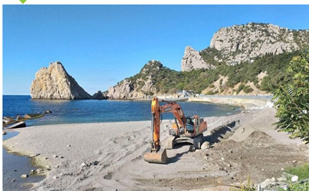
Рис. 3. Строительство берегоукрепительных сооружений на набережной пгт. Симеиз
